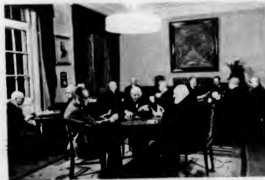
Der Gesellschaftsraum in Lichterfelde
